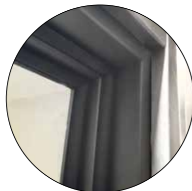
Carenatura fermapannello esterno in acciaio inox Perimetric Stainless steel profile
